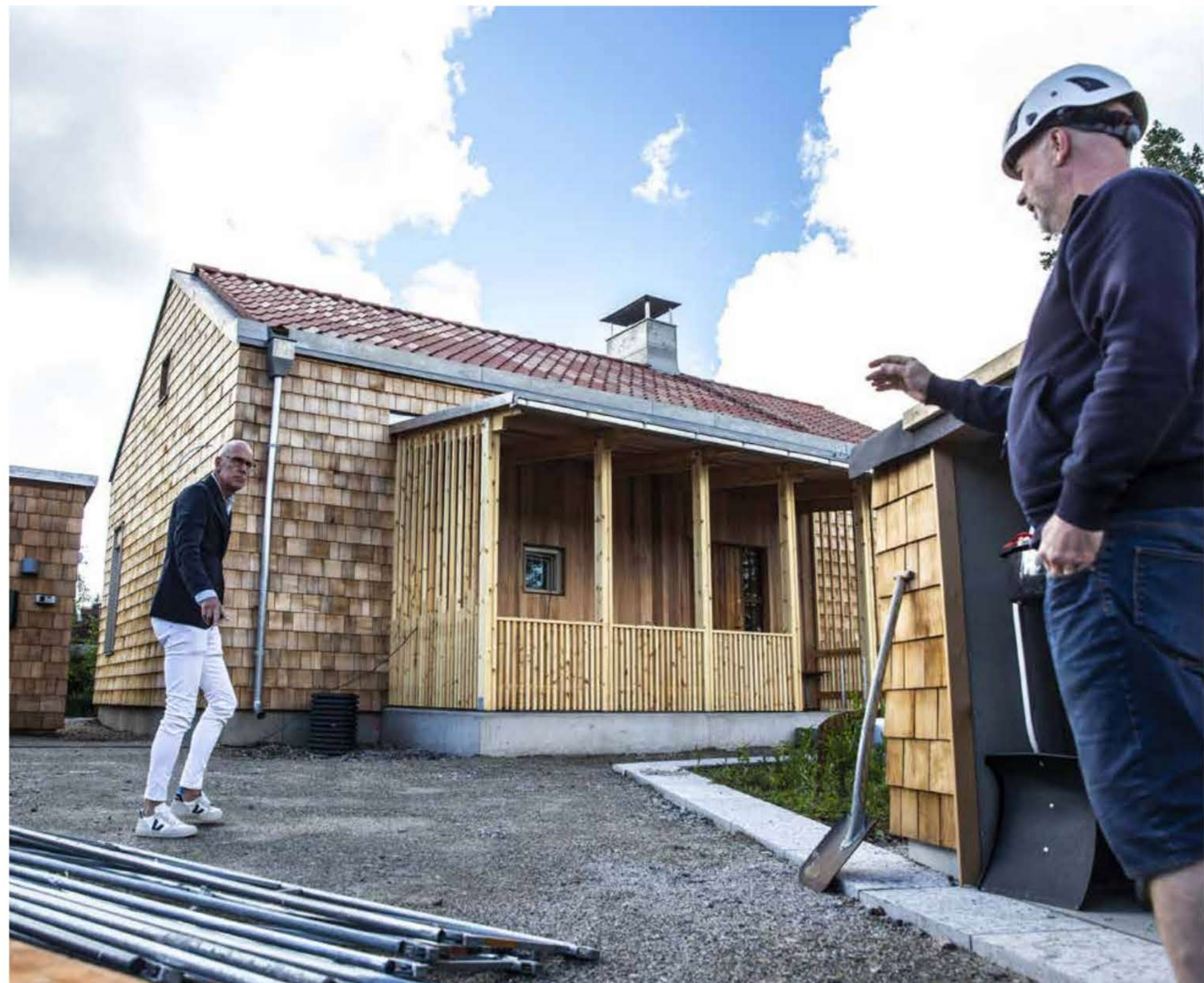
Husen på Källsprångsvägen byggs av flera unika material och tekniker, som bland annat korslimmat trä. Fredric Persson, platschef för bygget, beskriver att tekniken liknar hur modulerna på ett pepparkakshus fogas samman.
