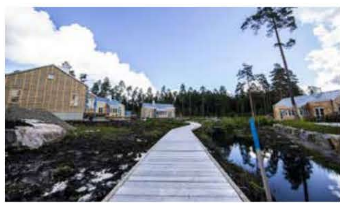
Fristad bygg har varit på plats i Viskafors sedan november. Stommarna är resta på nio av de 13 planerade husen.
